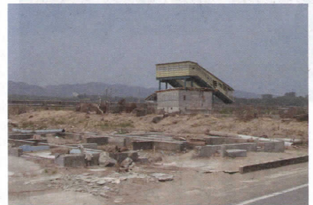
JR坂元駅の被災後の様子
